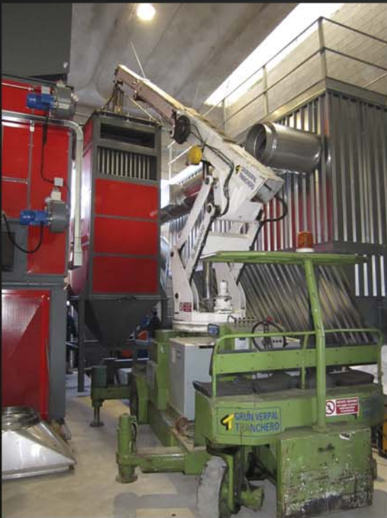
LAVORI IN SPAZI RISTRETTI
